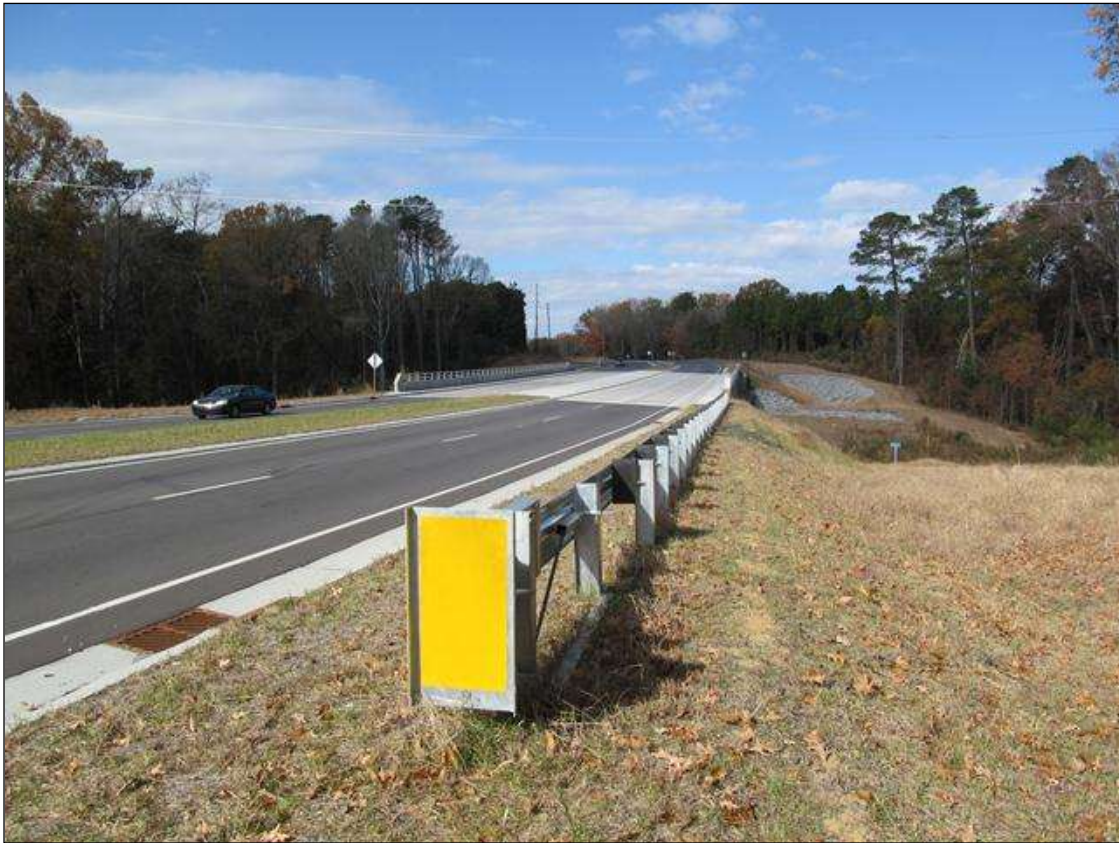
SE GUARDRAIL END TERMINAL. (NW END SIMILAR)
