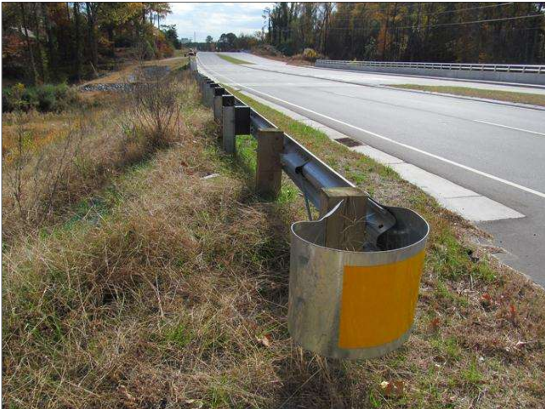
NE GUARDRAIL END TERMINAL
